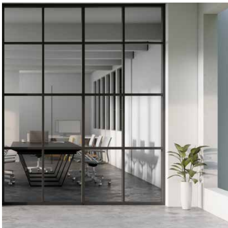
Festelement zur Abtrennung eines Besprechungsraums
